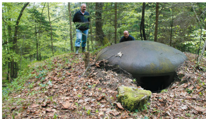
Jeklena kupola je le majhen del nekaj deset ton težkega ulitka, ki v obliki valja sega še kar nekaj metrov v globino in ki je za povrh še obilno obbetoniran. Predstavlja nadzemni, komaj vidni del ne ravno majhne utrdbe v sistemu Vallo Alpino, ki je bila zgrajena na mestu severnega portala zgornjega godoviškega železniškega predora. Ta portal so Italijani očitno zakamuflirali, saj danes o njem ni več nikakršnega sledu. (Foto: Peter Gedei)
