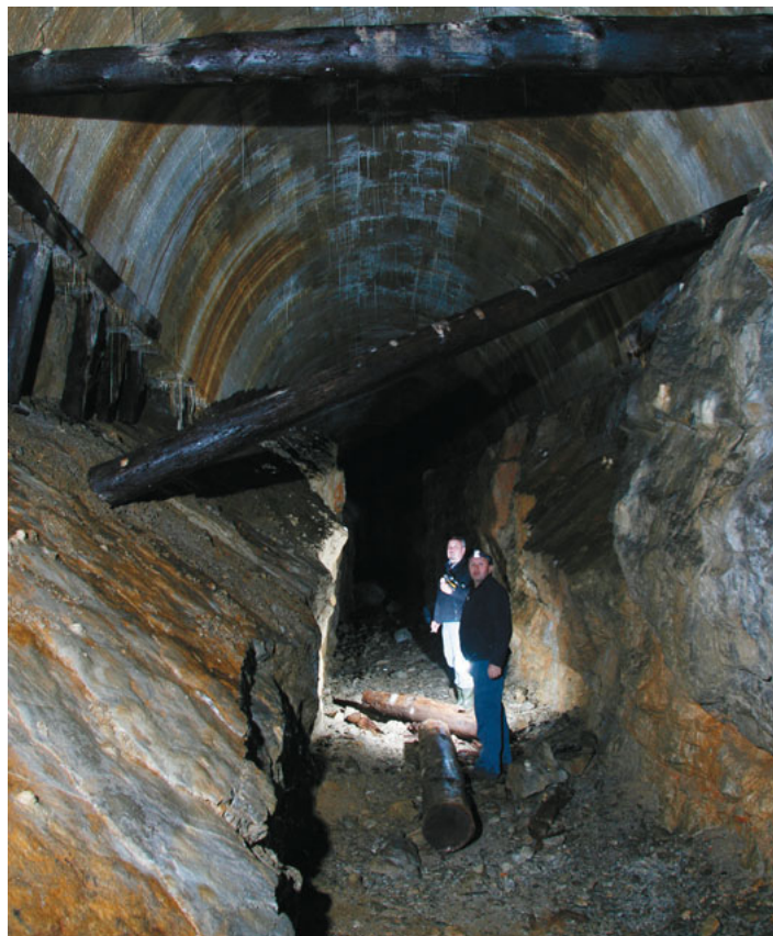
Kakih 250 metrov od južnega portala je zgornji obok predora že zgrajen (betoniran), spodnji del hribine pa še ne povsem odstranjen. Kot posledica del so se ohranile horizontalne podpore (stare skoraj sto let), ki jih na nekaterih mestih že prekriva siga. Na sliki sta avtor članka in dr. Andrej Mihevc z Inštituta za raziskovanje krasa ZRC Sazu iz Postojne. (Foto: Peter Gedei)
