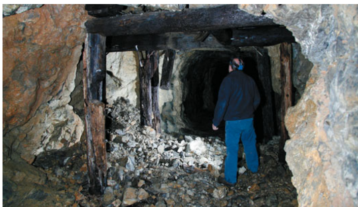
Izvozni rov v zgornjem godoviškem železniškem predoru le na nekaterih mestih ni dovolj stabilen, in ga je bilo treba podpreti. (Foto: Peter Gedei)
