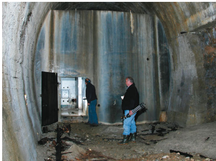
Severni del zgornjega godoviškega predora so med obema svetovnjima vojnama, v času ko je bil Godovič pod Italijo, prezidali v trdnjavo v sistemu Vallo Alpino (ta italijanski obrambni sistem je segal od Genove do Kvarnerja). Po drugi vojni je bilo razneseno, kar se je odnesti dalo, vendar je JNA še vedno do neke mere skrbela za te italijanske utrdbe. (Foto: Peter Gedei)
