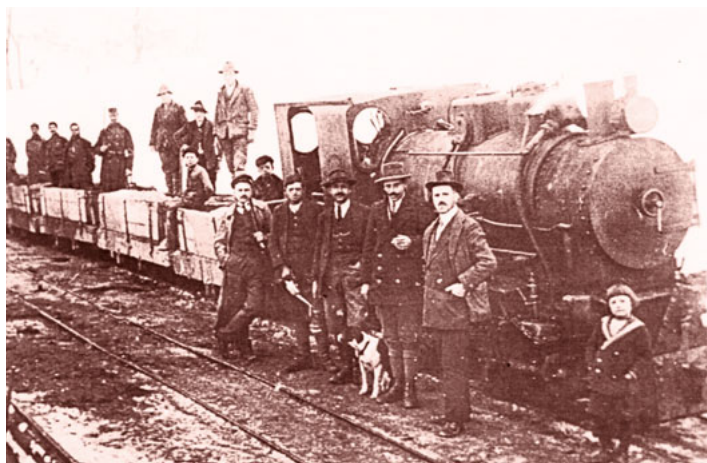
Gradnja nasipov za normalnotirno progo Logatec–Črni vrh v začetku leta 1917. Posnetek je nastal v bližini predora Naklo v Dolenjem Logatcu, eden od mož v ospredju na sliki pa je verjetno delovodja Lenassi. Pri delu so si pomagali z »mašinko«, kot so tedaj imenovali to ozkotirno parno lokomotivo, premog za njen pogon pa so kopal kar na trasi železnice, saj so pri gradnji predora naleteli na dovolj kakovostno, debelejšo premogovo plast.
